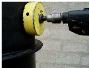
Lyukmarása megfelelő szerszám segítségével
