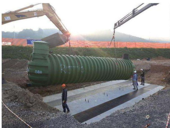
4. sz kép: A tartály telepítése
