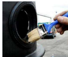
A gumitömítés behelyezése
