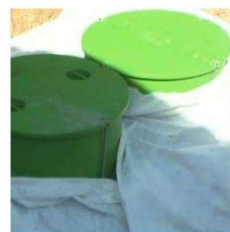
Amikor a tartályokat a terepszinttől 20 - 30 cm-re temették el, fektesse le a geotextíliát
