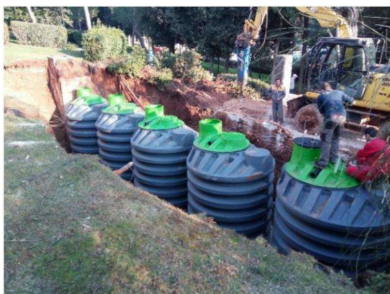
5.sz. kép: Tartályok sorba telepítése
