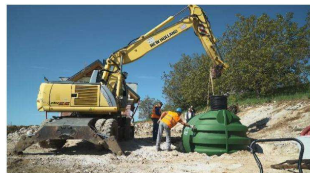
3. sz. Kép: A tartály telepítése
