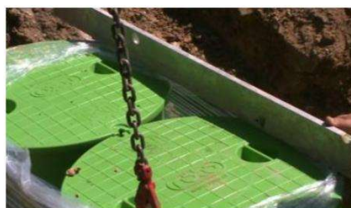
Győződjön meg arról, hogy a fedél és a terep egyszinten van
