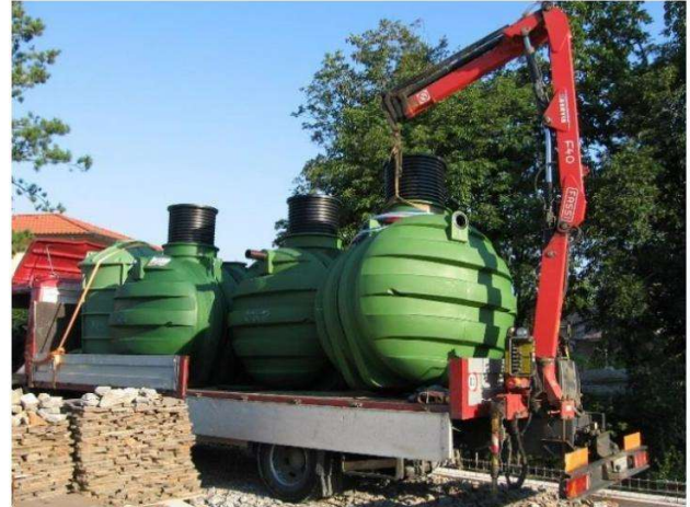
1 sz. Kép: Megfelelő szállítás és lepakolás
