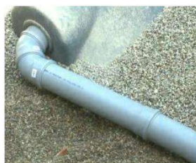
Óvatosan temesse el a szivattyúállomást megfelelő 4-16 mm-es kavicssal
