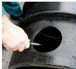
A lyuk kerületének kitisztítása
